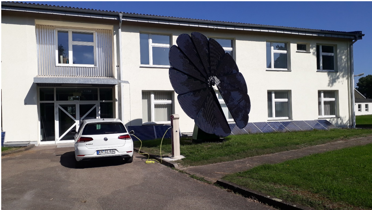
Abb. 7: Oben: Foto des Gesamtareals IKT-Siedlung Hohentengen, Mitte: Lageplan mit Nummerierung der Gebäude, Unten: Frontseite von Gebäude #6 mit OCPP 1.6; 11/22kW Ladesäule und eGolf (36kWh), nachgeführter PV-Blume (ca. P_{max}=2kW_{PV} ) und stationärer temporär an Hauswand angeordneter PV-Anlage (ca. P_{max}=4kW_{PV} ).
