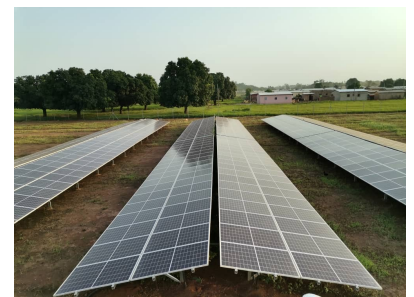
Mali: Ländliche Elektrifizierung
