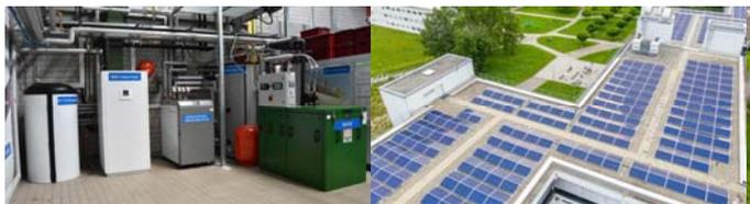
Eingebundene DER an der HS Reutlingen, links: Labor mit Wärmepumpe, BHKW, AdKM und Wärmespeicher, Quelle: HS Reutlingen; rechts: PV-Anlage auf dem Dach auf dem Campus, Quelle: Umweltministerium/Björn Hänsler©
