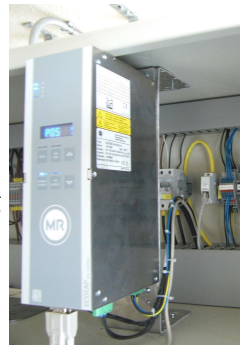
Stufenschalter (rONT)
