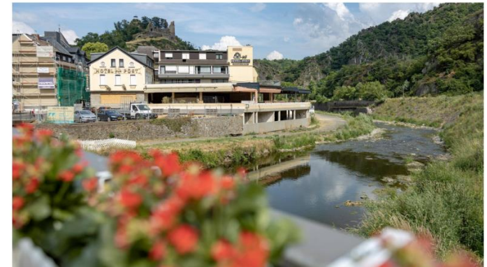
Wiederaufbau an der Ahr, zwei Jahre nach der Flutkatastrophe im Juli 2021. Viele Gebäude werden am gleichen Ort wieder errichtet. Die Gefahr einer erneuten Überflutung bleibt. (imago / Maro John)
